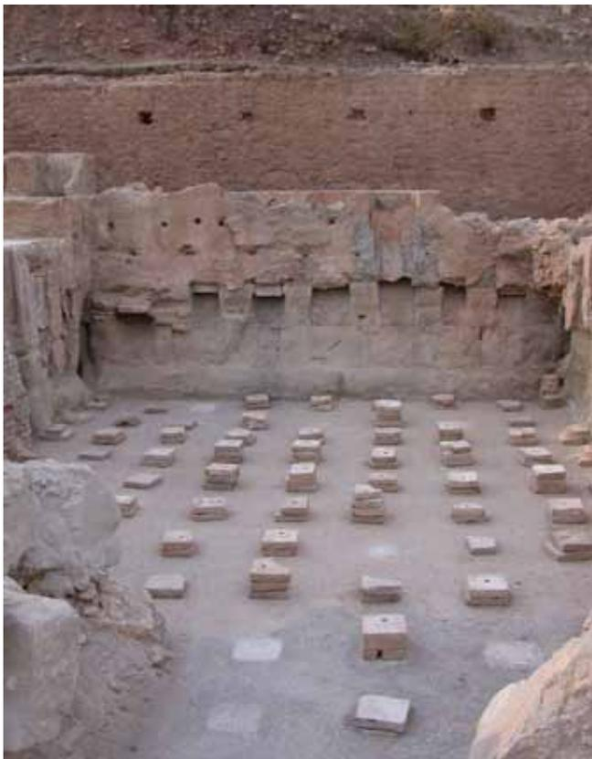
Figura 11. Detalle del hypocaustum del tepidarium y los conductos tallados en los muros de las Termas I.
