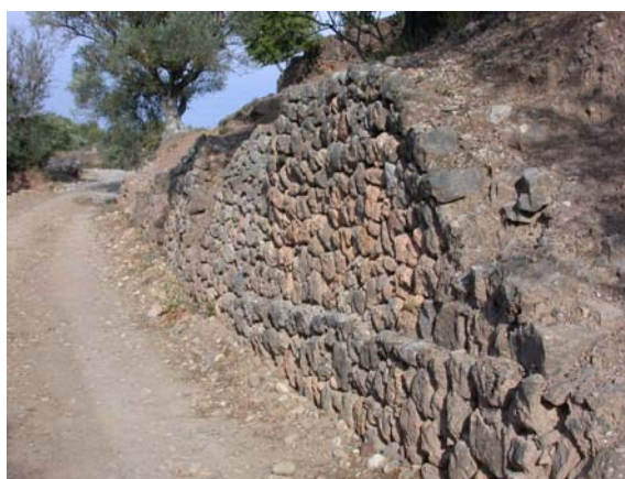
Fig. 5. Bancales agrícolas realizados con los sillarejos de la ciudad romana. Para sujetar mejor la tierra se emplean troncos de árbol dispuestos perpendicularmente a la pared de piedra del bancale.
