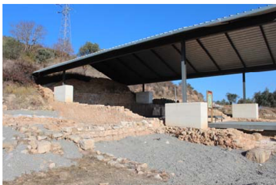
Fig. 10 Acondicionamiento del Exterior de la Curia
