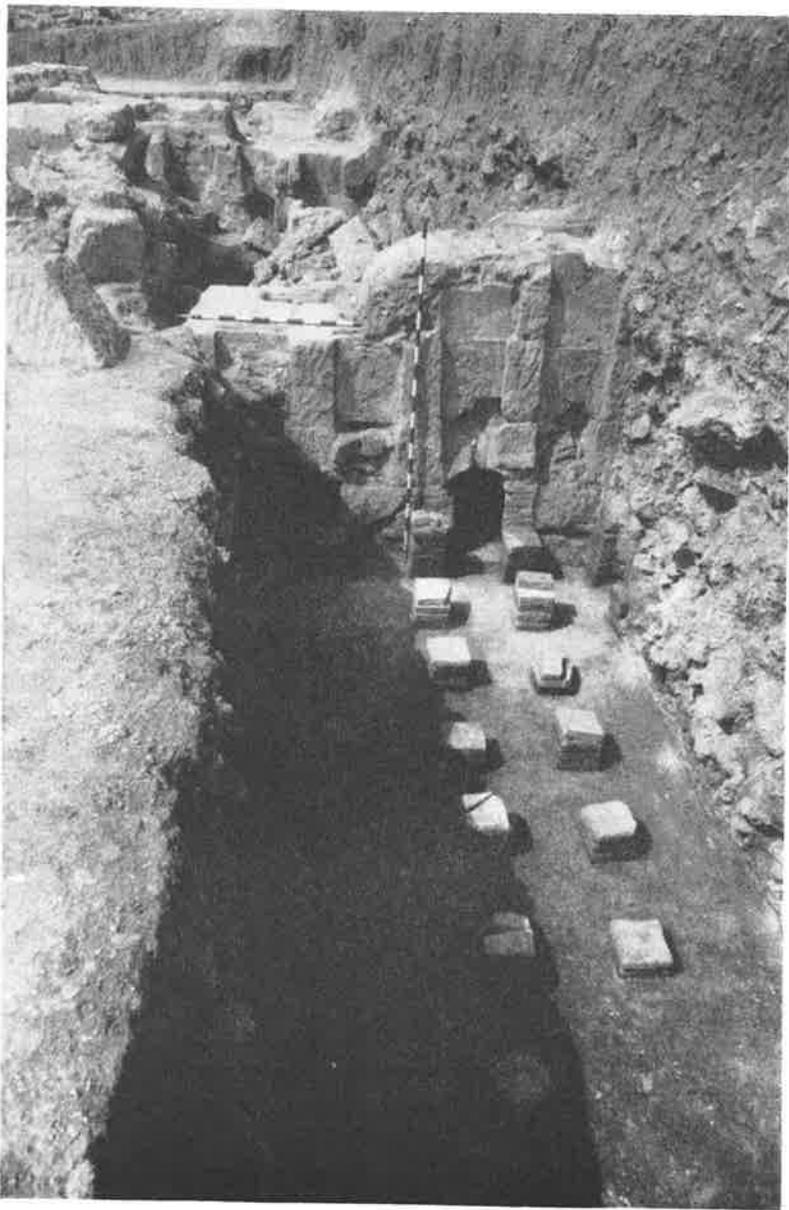
Lám. VI. Parte Norte del *Tepidarium*, a nivel del suelo del *hypocaustum*, vista desde el Este. Obsérvese el sistema de calefacción instalado en los muros con las tejas que cierran los conductos. En la parte inferior puede verse una abertura por donde pasaba el aire caliente desde la *cella soliaris*.
