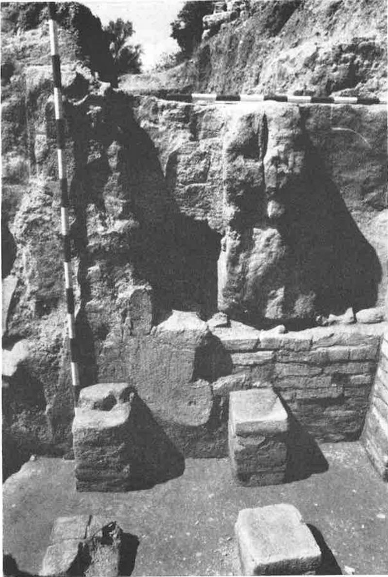
Lám. IX. Muro Oeste de la estancia cálida con su sistema de calefacción; obsérvese el murete latericio, que protegía la base de la pared del calor, y el revestimiento de mortero que se conserva en la entrada del conducto mural para el aire caliente.
